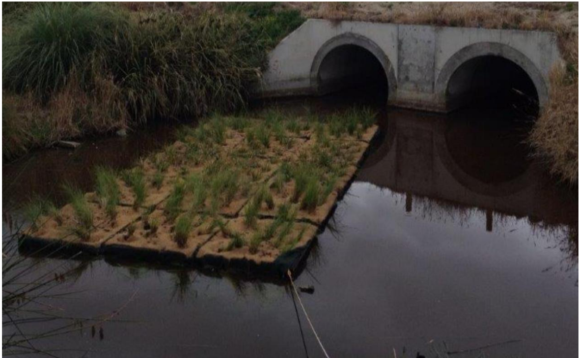
Kuva 7. Kuvassa kelluva kosteikko, joka koostuu vesikasveista kelluvalla keinotekoisella matolla. (Livingwater.net.nz, 2015)
