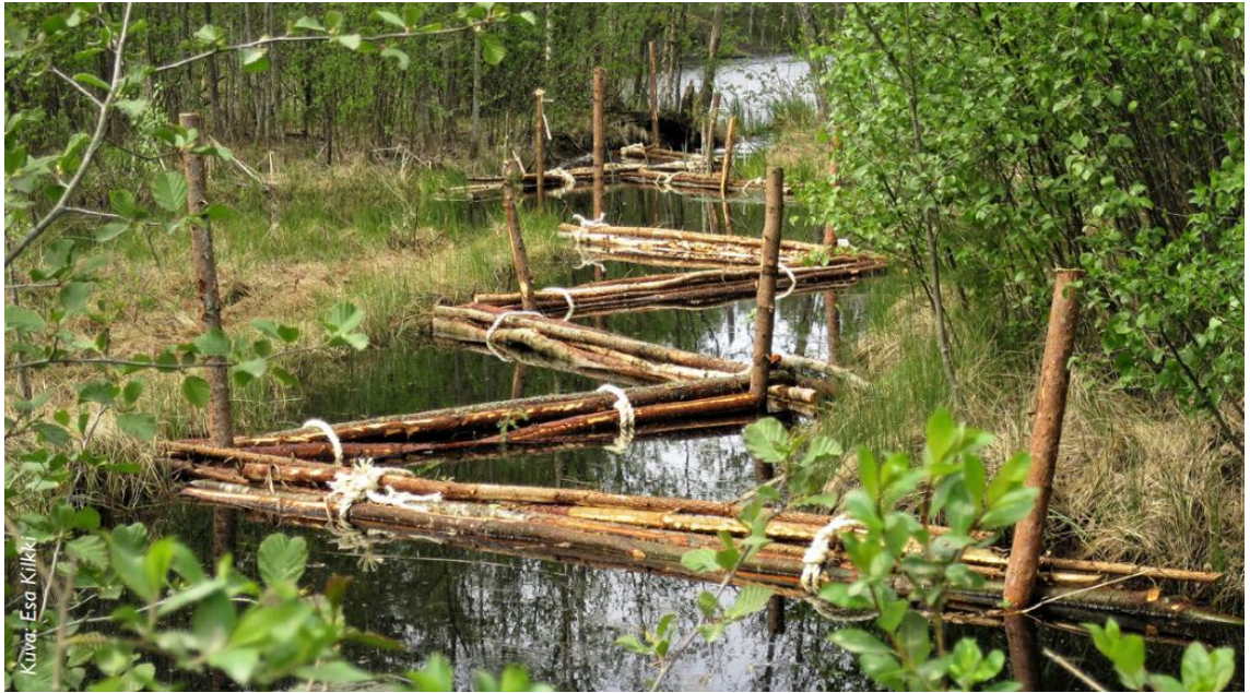
Kuva 4. Puunrankaniput asennettuna Saimaan Vehtataipaleen ojakohteessa. (Vuori ym., 2021)
