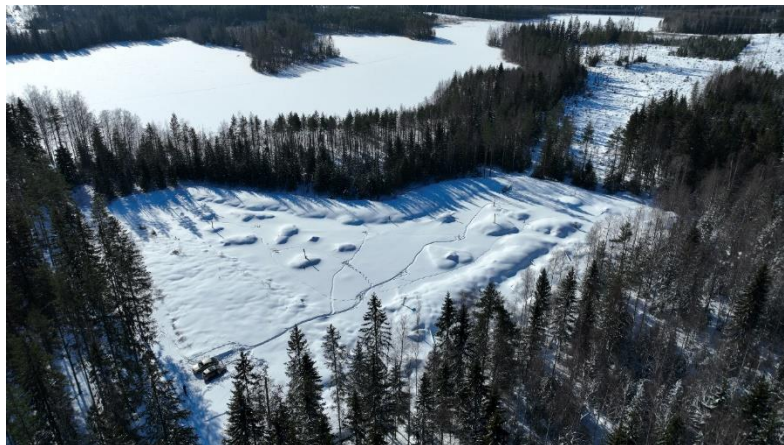
Kuva 4 Salpamajan kosteikolle asennettiin maaliskuussa 2023 yhteensä 20kpl liikennemerkkin putkivartta 10 putkipesää varten.
