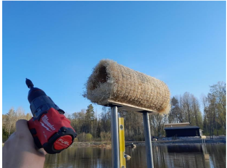
Kuva 5 Pesäputki kiinnitetään jalustaputkiin kiinnitysrautojen avulla
