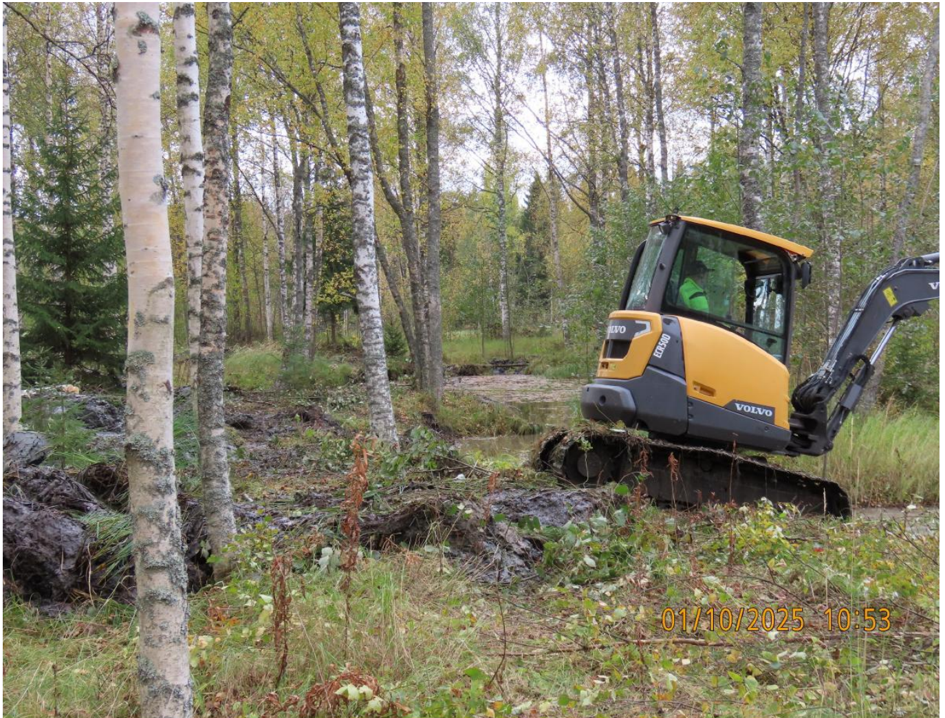
Kuva 3. Juurikankanavan kosteikon kunnostustyöt käynnissä syksyllä 2025 ©Vesa Partinen
