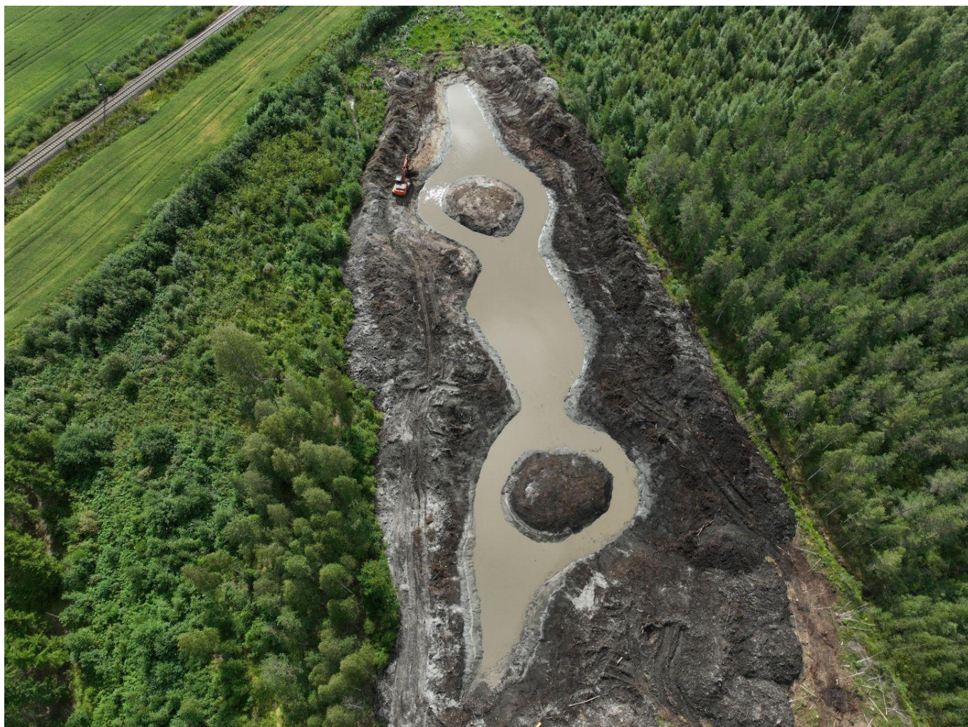
Kuva 1. Karpalosuo kosteikon työmaa elokuussa 2025.
