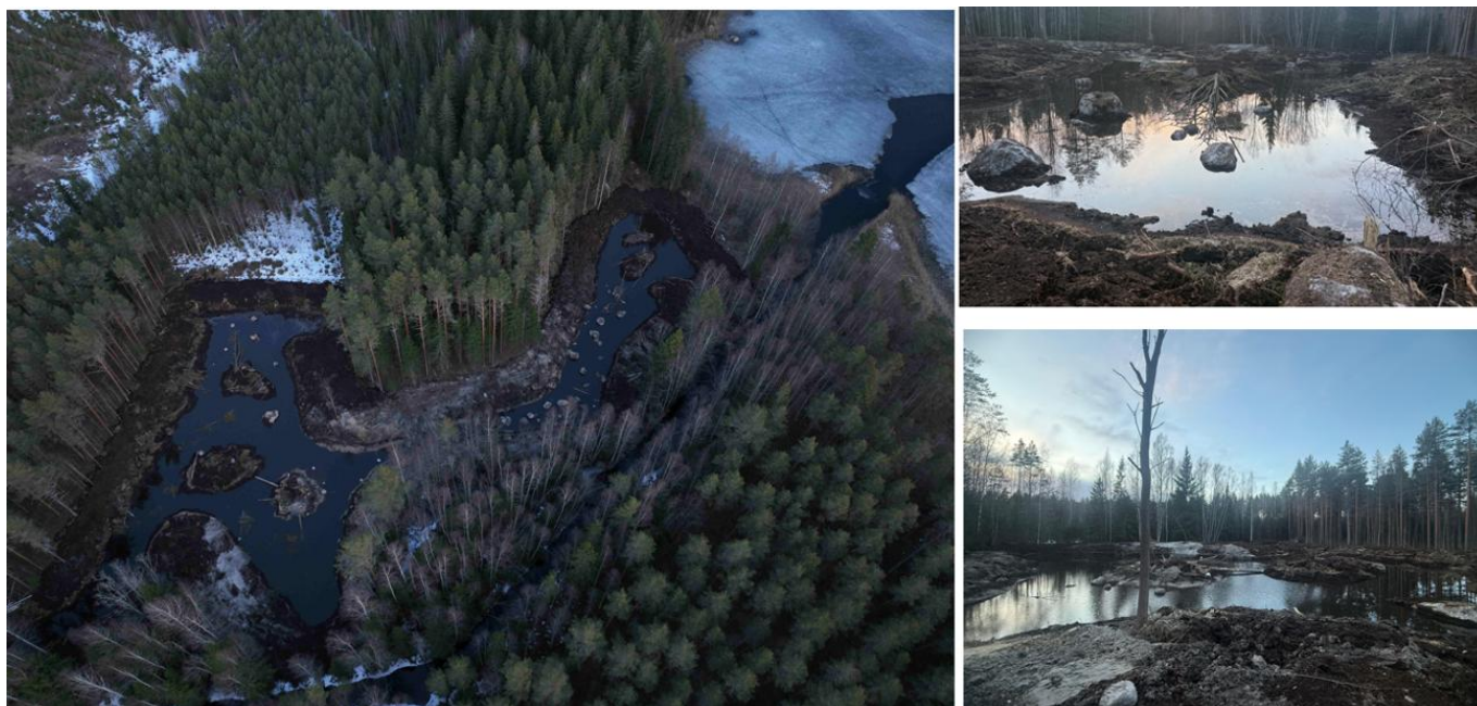
Kuva 8. Joksaaren kosteikko kaivuutöiden jälkeen 24.3.2026.
