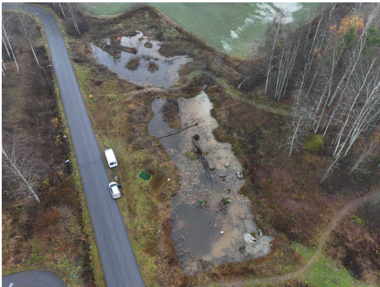
Kuva 5. Ilmakuva Torpparinrinne 1 kosteikon kunnostustöistä marraskuussa 2025.
