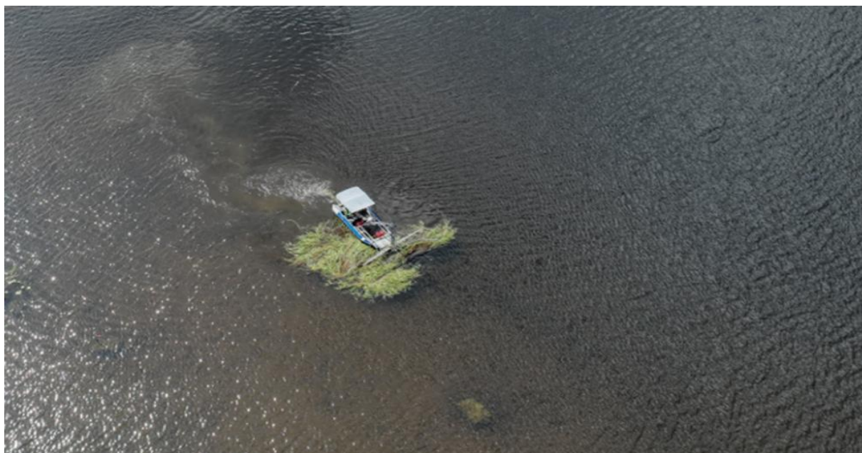
Kuva 9. Niittomateriaalia työnnettiin rantaan veneeseen kiinnitetyn niittopään avulla.
