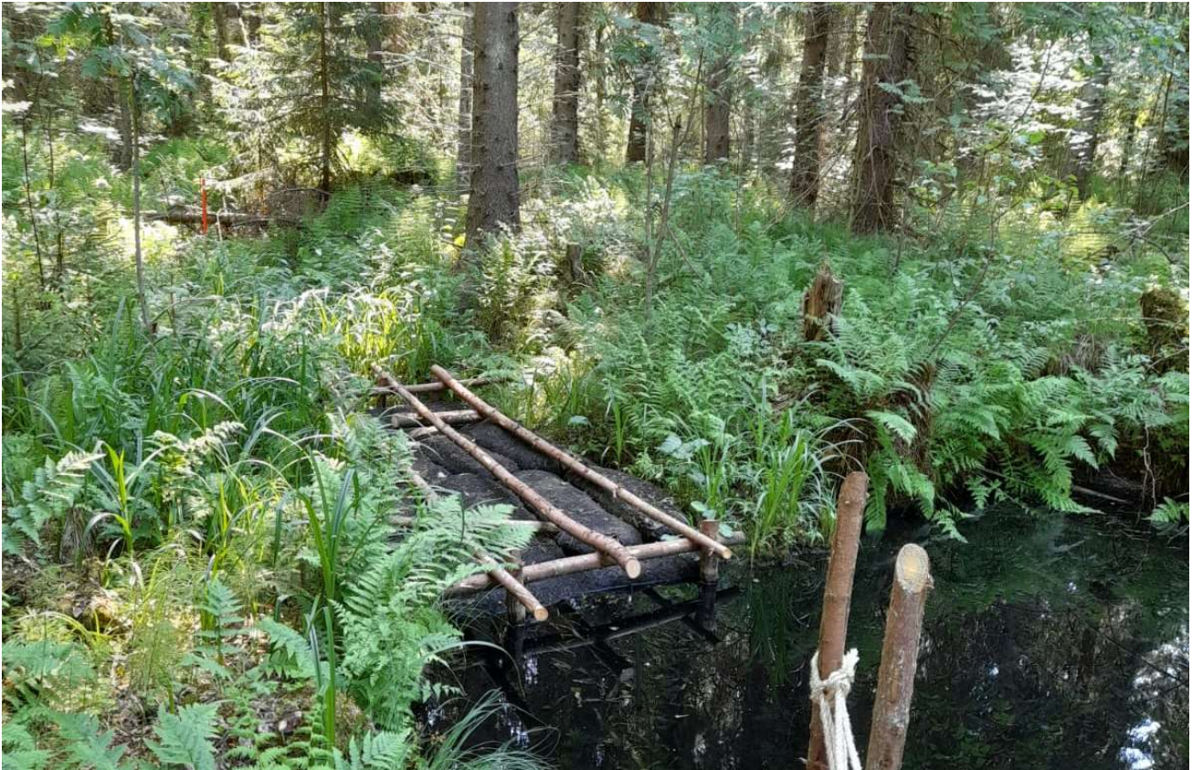
Kuva 8. Puuhake-biohiilisuodatinsäkit altaan lähtöuomaan asennettuna ensimmäisenä vuonna kesäkuussa 2023.
