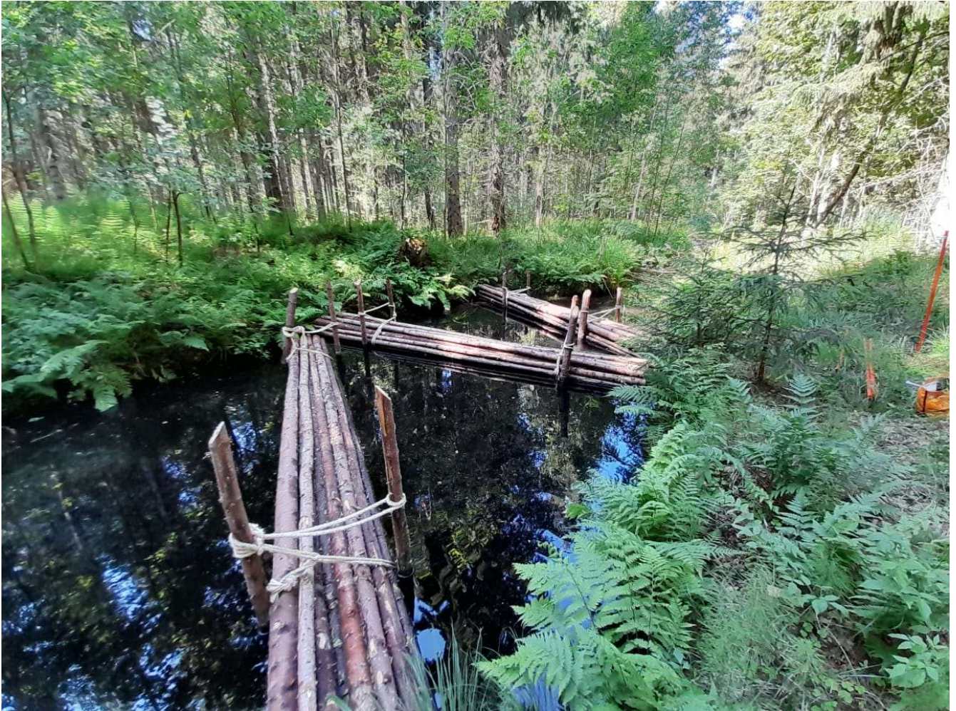
Kuva 7. Altaalle asennetut puurankaniput kuvattuna ensimmäisen vuoden kesäkuussa 2023.
