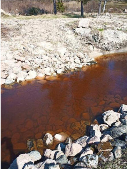
Kuva 12 & 13. Hattukorven laskeutusallas (oik.) ja sen alapuolinen kivetty pohjapato (vas.).
