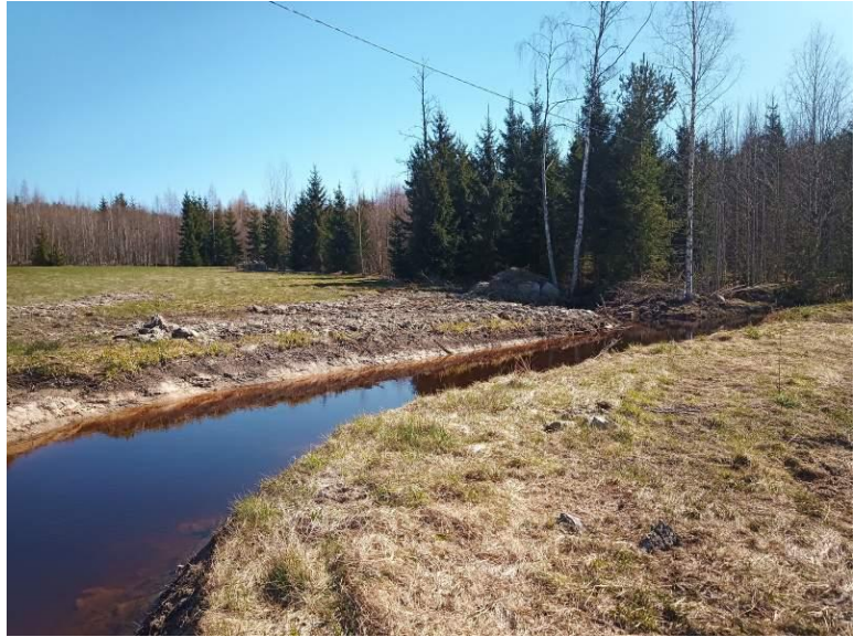
Kuva 12 & 13. Hattukorven laskeutusallas (oik.) ja sen alapuolinen kivetty pohjapato (vas.).
