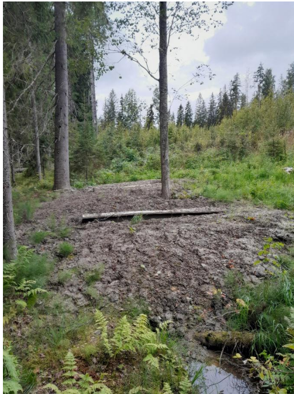
Kuva 14. Kurkisuon pato. Ajan myötä, kasvillisuuden leviäminen patorakenteelle maastouttaa sen lopullisesti ja osaltaan lisää rakenteen vakautta.
